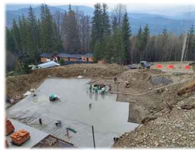
Щебенева та бетонна підготовка під фундамент
