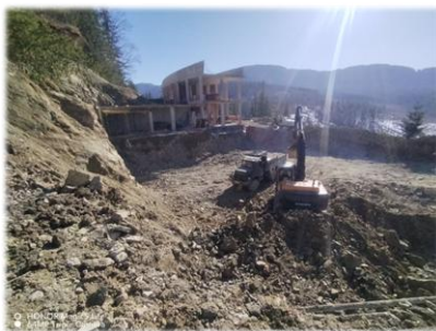
Розробка котловану ресторанно-технічного блоку
