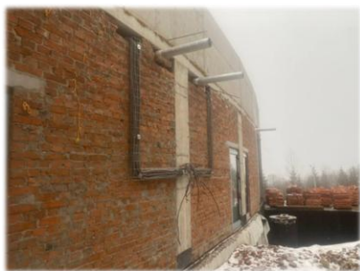
Влаштування інженерних мереж в готельному блоці
